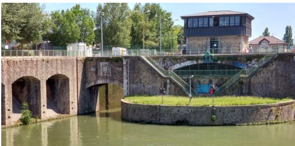
Canal Saint-Denis et PC de régulation
